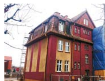
Trwają prace remontowo - adaptacyjne w budynku przyszłego ŚDS dla osób z chorobą Alzheimera
