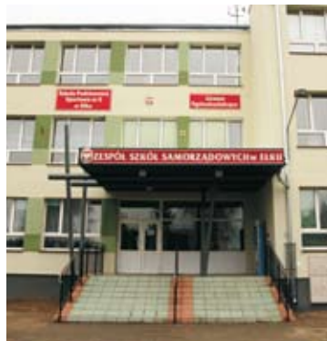
Termomodernizacja Zespołu Szkół Samorządowych
