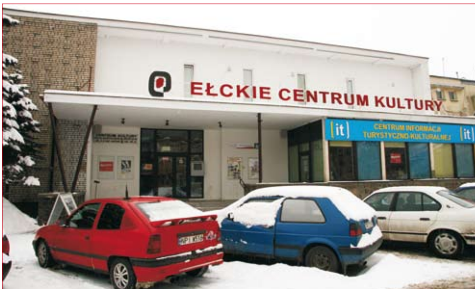
ECK przed remontem
